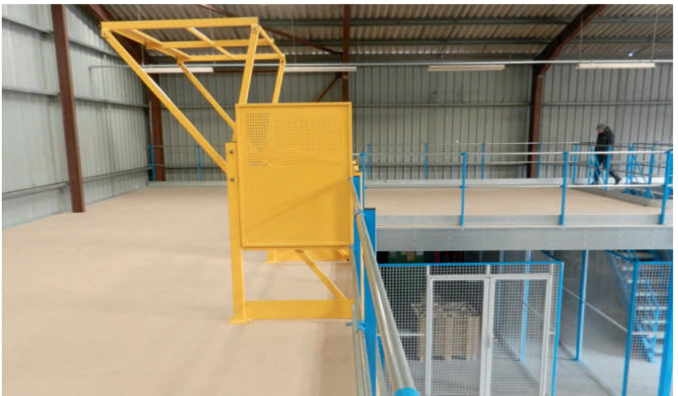
Avec SAS de sécurité à l'étage pour la manutention sécurisée des palettes et avec cloison grillagée sous structure pour définir des zones avec accès réservé.
