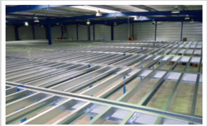
*Structure intégrée à l'ossature du bâtiment*
